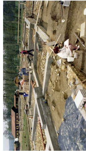
Erste Grundmauern des Badneubaus
